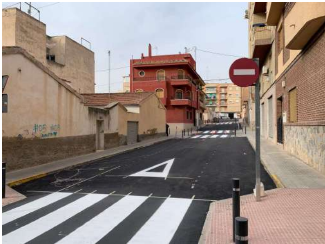
Actuaciones de reasfaltado en las vías públicas
