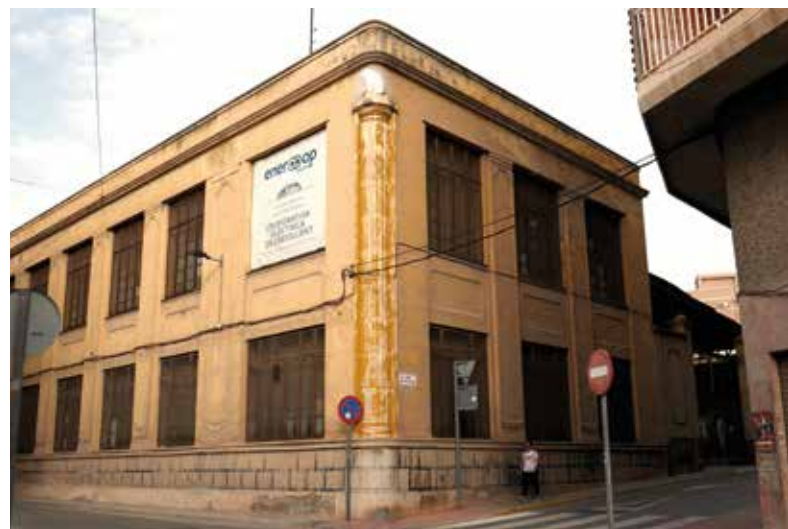
Figura 12.- Fachada de la Fábrica de Alfombras Universal, futura sede del Museo de la Alfombra de Crevillent (2022).
