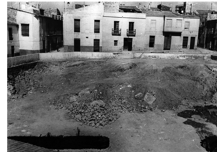
Fotografía obras de urbanización Plaza Dr. Mas Candela (1965)
