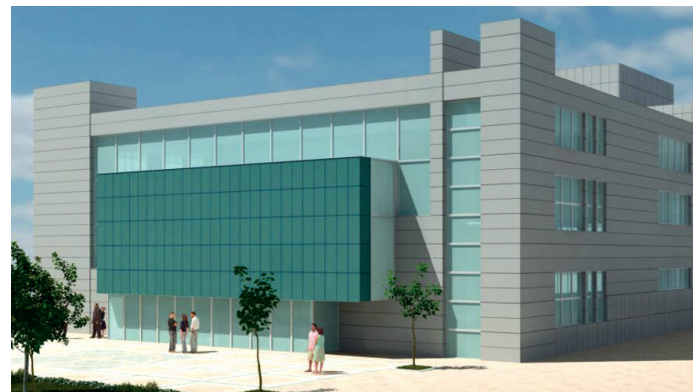
Fachada del nuevo Teatro Chapí en construcción.
