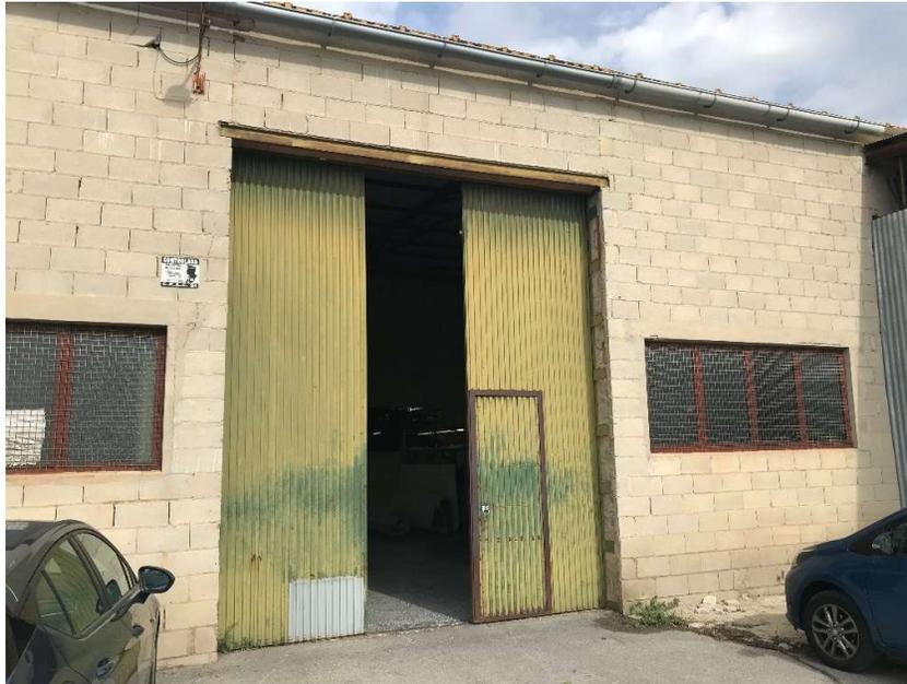
La edificación 2, se encuentra anexa por el este con la edificación 1 y está formada por chapa metálica en todos sus laterales y tejado. Está construida a 1 agua con perfiles IPE y tiene unas dimensiones de 128,73 m<sup>2</sup>. Se encuentra afectada toda su superficie. **Valorar.**
