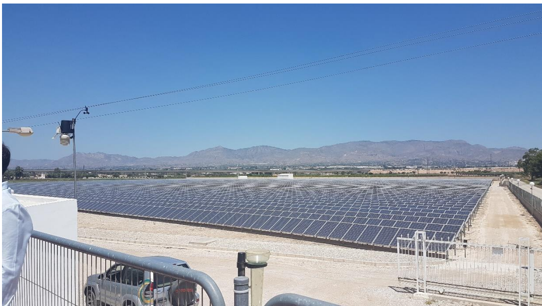
Fotografía 13. Instalaciones Cooperativa Eléctrica San Francisco de Asís. Fuente: Elaboración propia.
