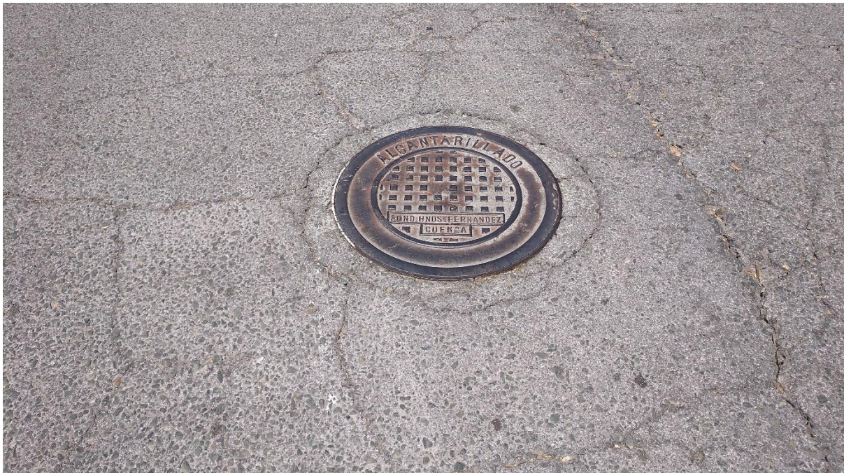
Fotografía 25. Tapa perteneciente a pozo de la red de saneamiento del polígono. Fuente: Elaboración propia.
