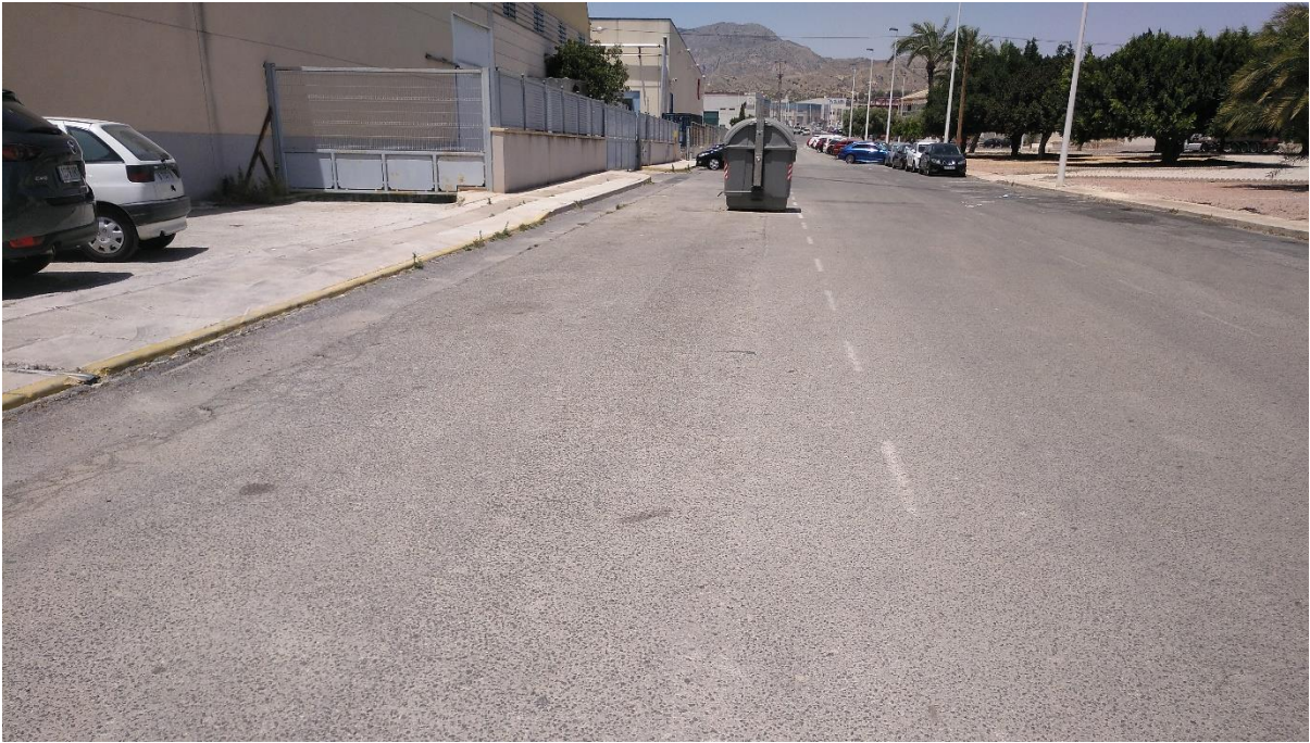
Fotografía 15. Ejemplo del estado de uno de los tramos de calzadas del polígono. Fuente. Elaboración propia.
