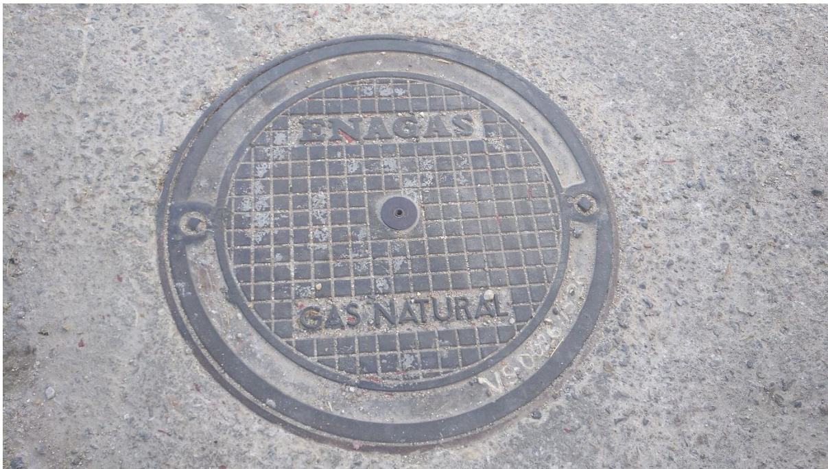
Fotografía 32. Tapa perteneciente a la red de gas natural observada en el polígono. Fuente: Elaboración propia.
