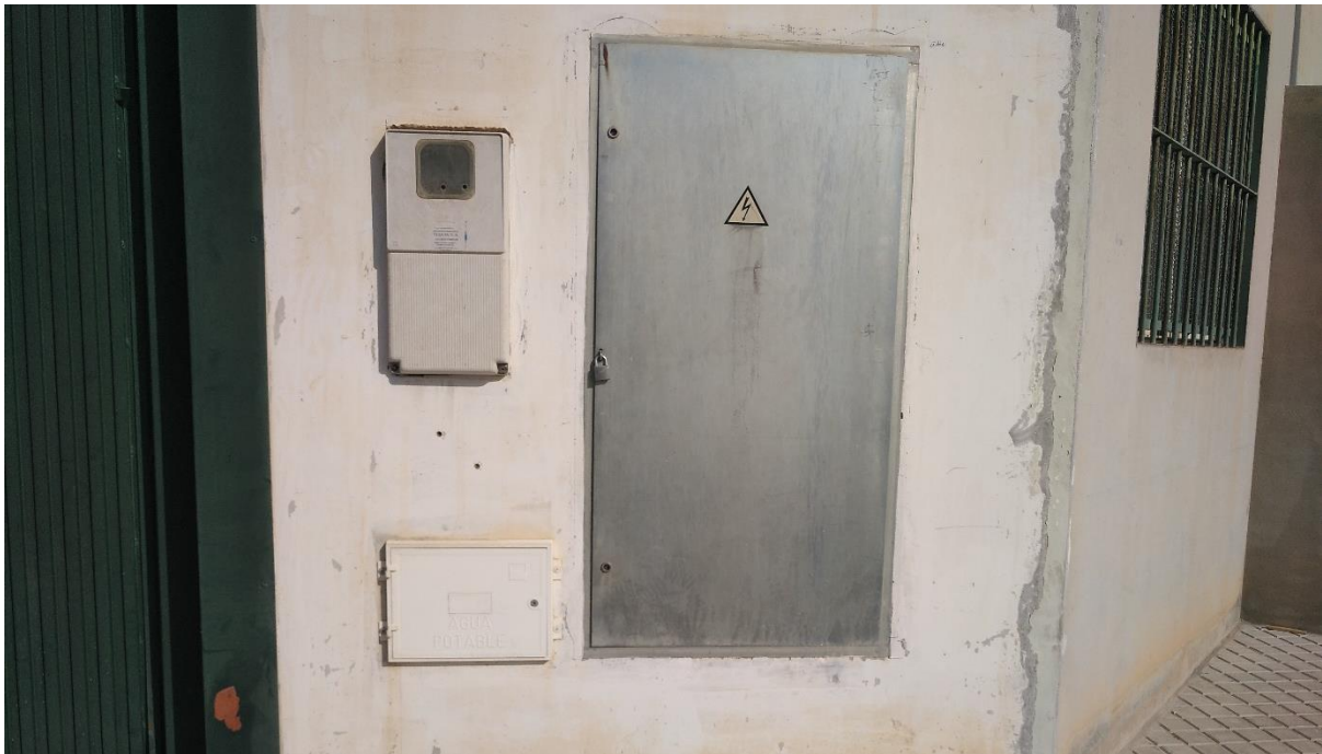
Fotografía 31. Conexión a red de suministro de agua potable y electricidad de una nave del sector industrial Este. Fuente: Elaboración propia.
