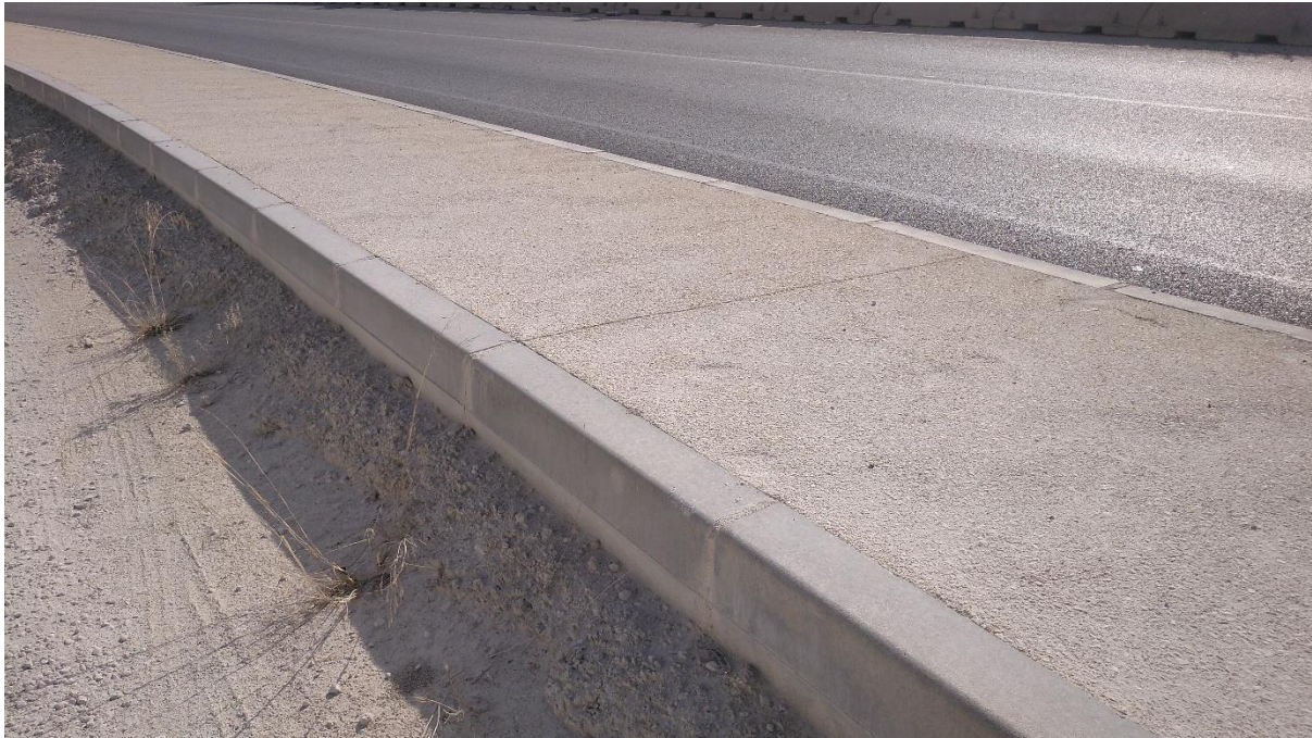
Fotografía 12. Acera perteneciente a la calle zona este perimetral del polígono. Fuente. Elaboración propia.
