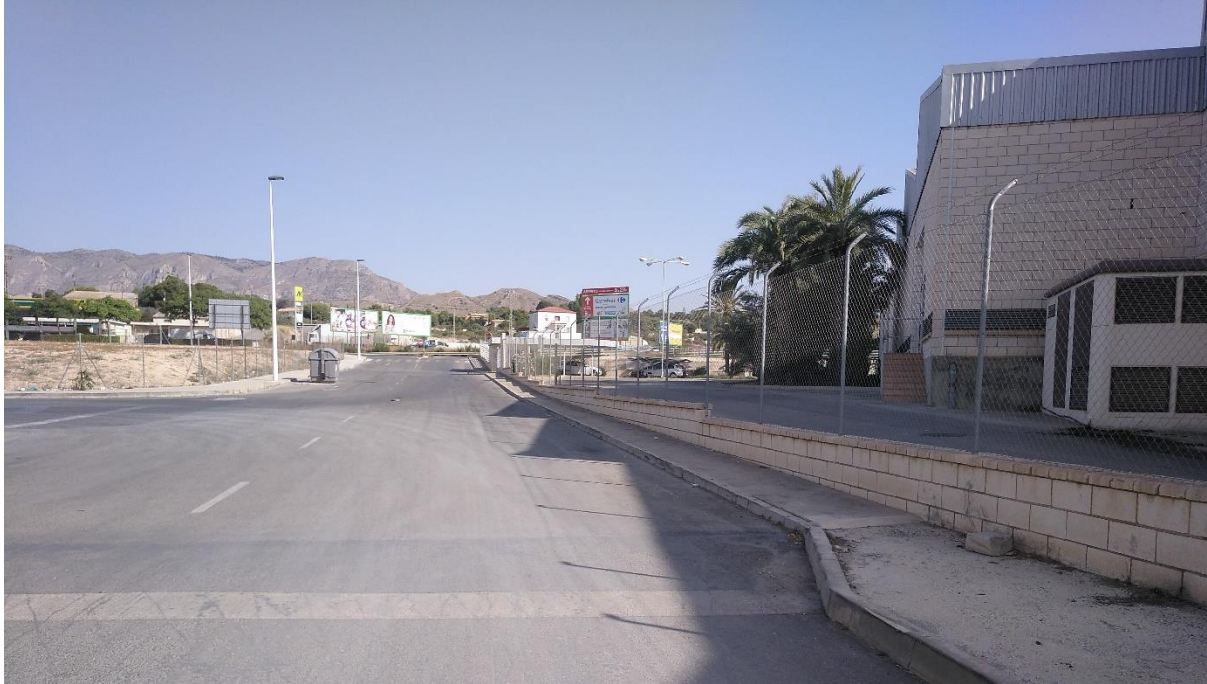
Fotografía 8. Calle zona este del polígono. Fuente. Elaboración propia.
