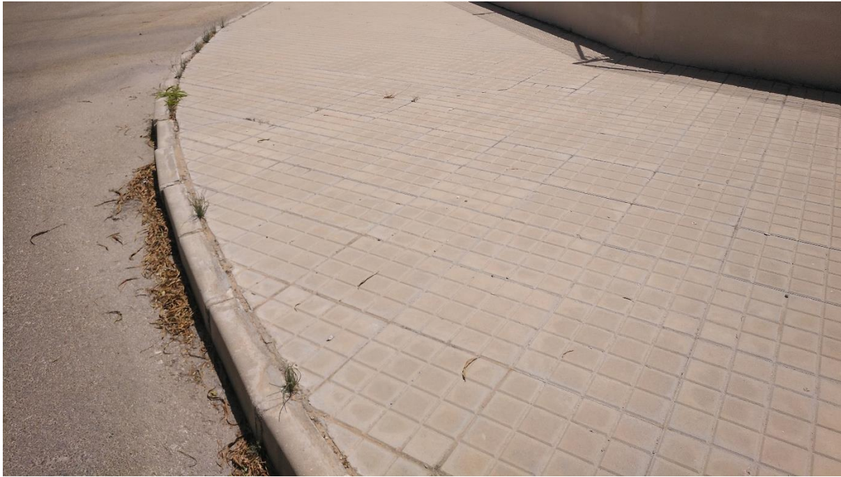
Fotografía 7. Ejemplo del estado de las aceras del polígono. Fuente. Elaboración propia.
