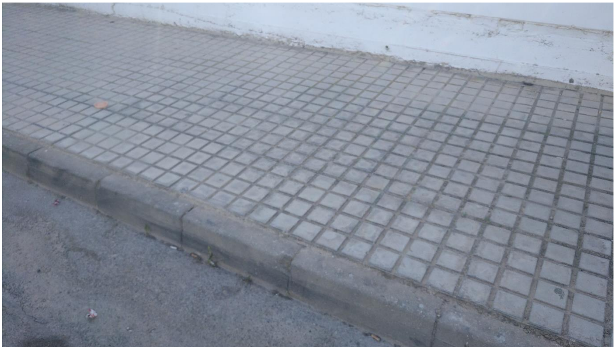
Fotografía 5. Aceras perteneciente a la C/ A del polígono. Fuente. Elaboración propia.
