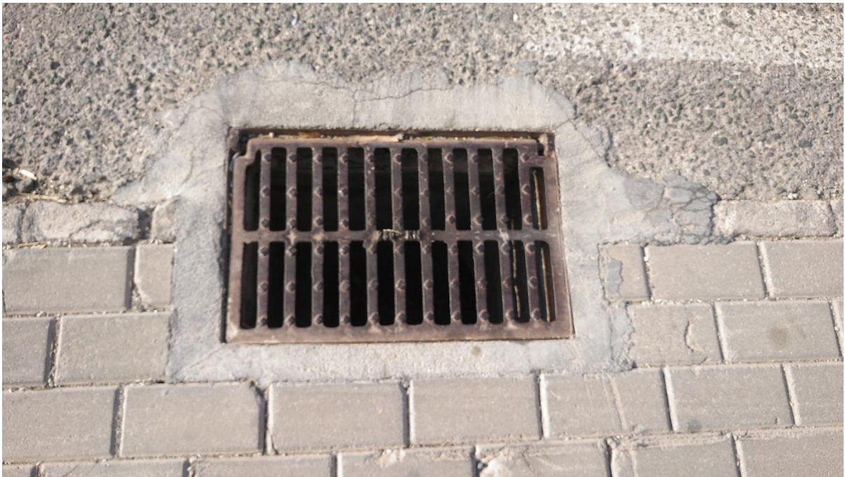
Fotografía 27. Elementos de drenaje superficial en C/ Rellu del polígono. Fuente: Elaboración propia.
