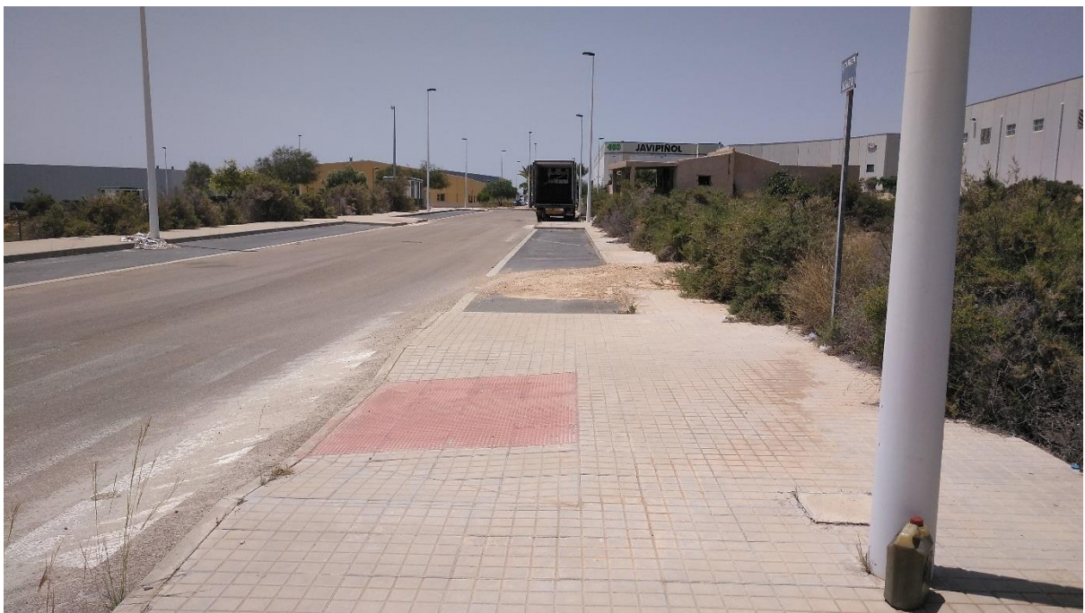
Fotografía 10. Ejemplo de invasión de vegetación y sedimentos en las aceras del polígono, C/ Adsubia. Fuente. Elaboración propia.
