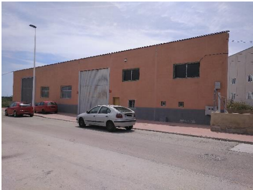
Fotografía 14. Nave 79. Fuente: Elaboración propia
