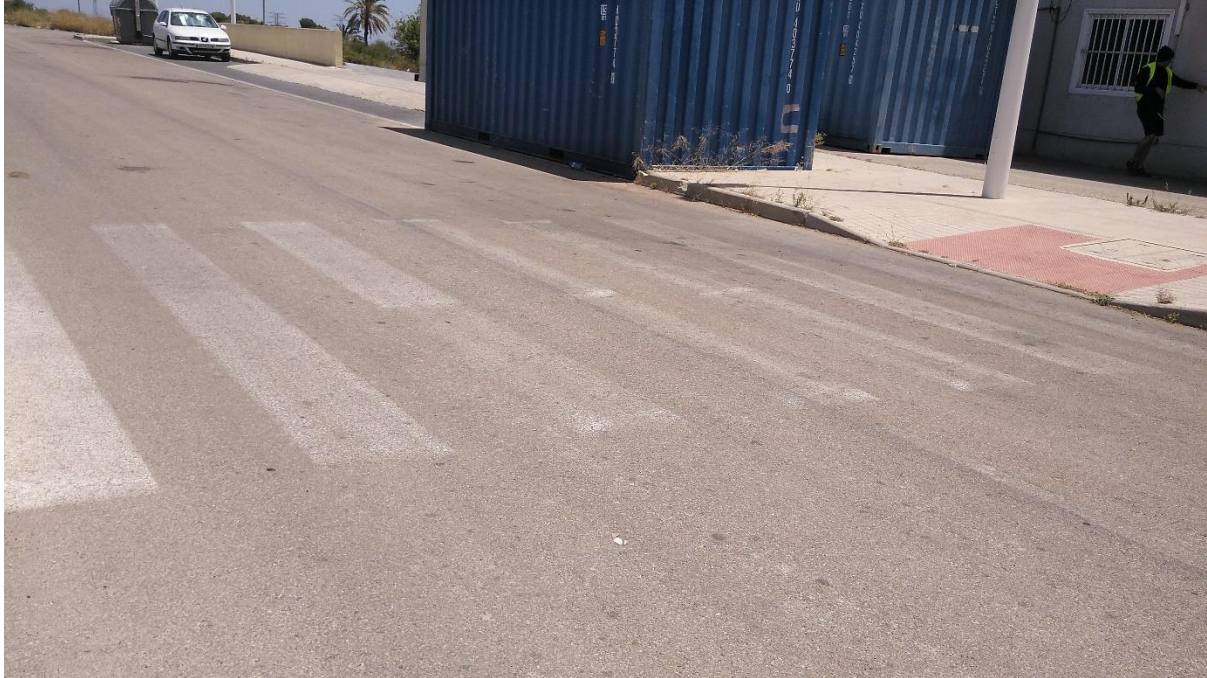
Fotografía 17. Ejemplo estado pintura pasos peatones polígono Crevillente Industrial. Fuente: Elaboración propia
