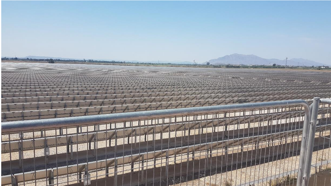
Fotografía 12. Instalaciones Cooperativa Eléctrica San Francisco de Asís. Fuente: Elaboración propia.
