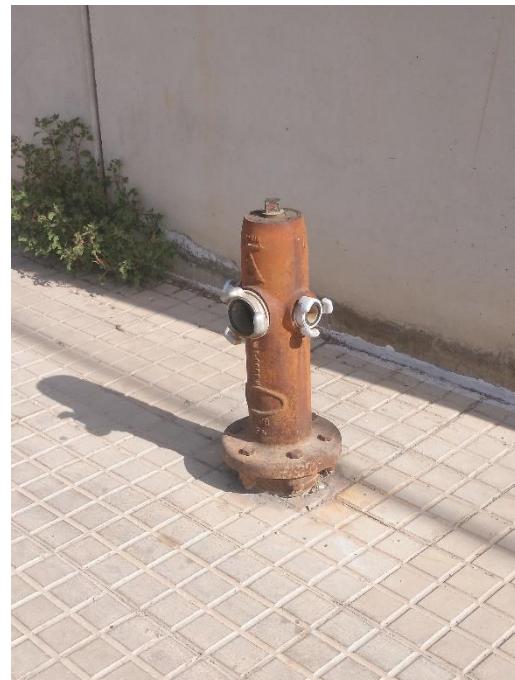
Fotografía 33 y 34. Modelo de hidrante presente en el polígono Fuente: Elaboración propia.
