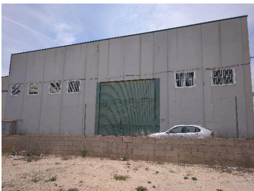
Fotografía 12. Nave 73. Fuente Elaboración propia
