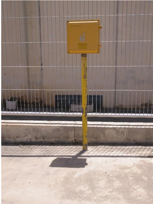
Fotografía 36 y 37. Contador y tapa perteneciente a la red de gas natural polígono I-4. Fuente: Elaboración propia.
