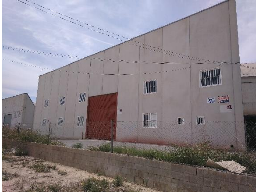
Fotografía 13. Nave 74. Fuente Elaboración propia
