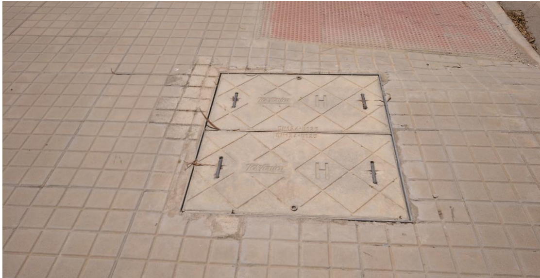
Fotografía 31 . Arqueta de telecomunicaciones polígono Crevillente Industrial. Fuente: Elaboración propia
