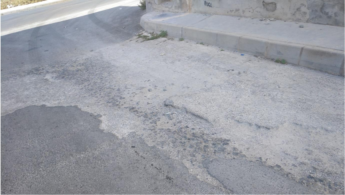
Fotografía 15. Estado pavimento calle polígono Este. Fuente. Elaboración propia.
