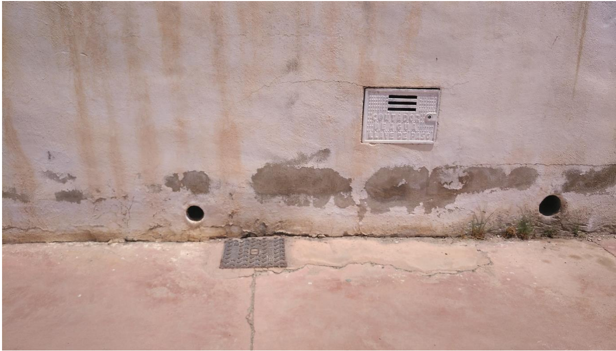
Fotografía 34. Conexión a red de suministro de agua potable del sector industrial I-4. Fuente: Elaboración propia.
