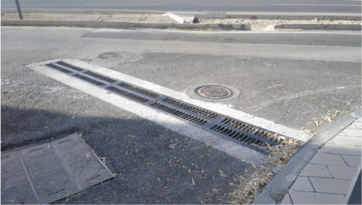
Fotografía 26. Elementos de drenaje superficial en C/ Rellu del polígono. Fuente: Elaboración propia.
