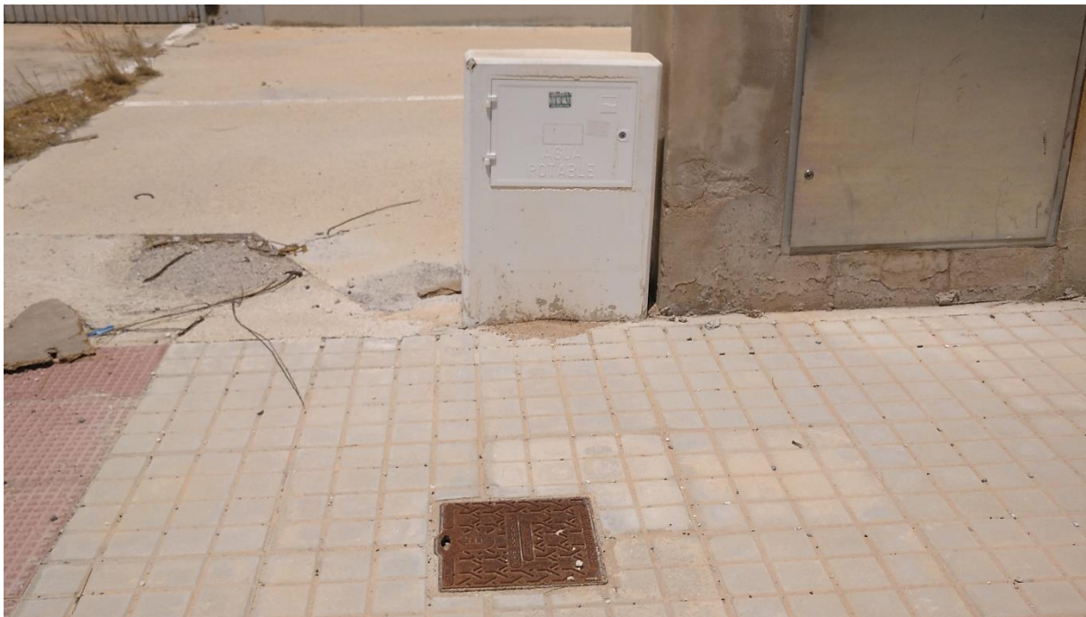
Fotografía 29. Conexión a red de suministro de agua potable. Fuente: Elaboración propia.
