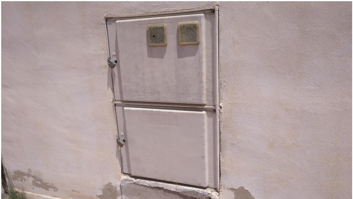
Fotografía 35 . Conexiones para la electricidad del polígono I-4. Fuente: Elaboración propia
