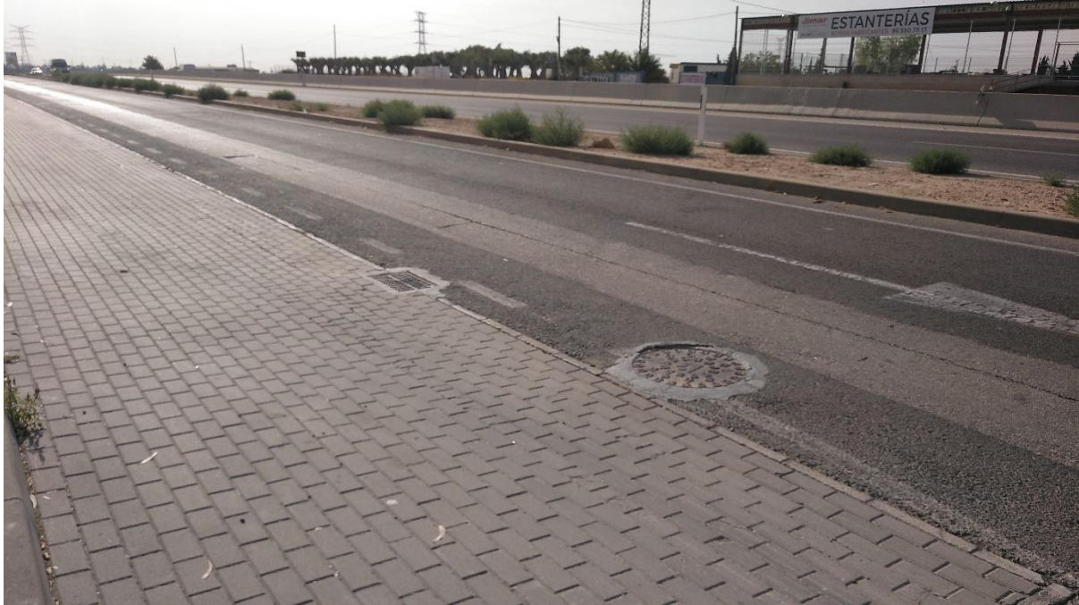
Fotografía 28. Elementos de drenaje superficial en C/ Relleu del polígono. Fuente: Elaboración propia.
