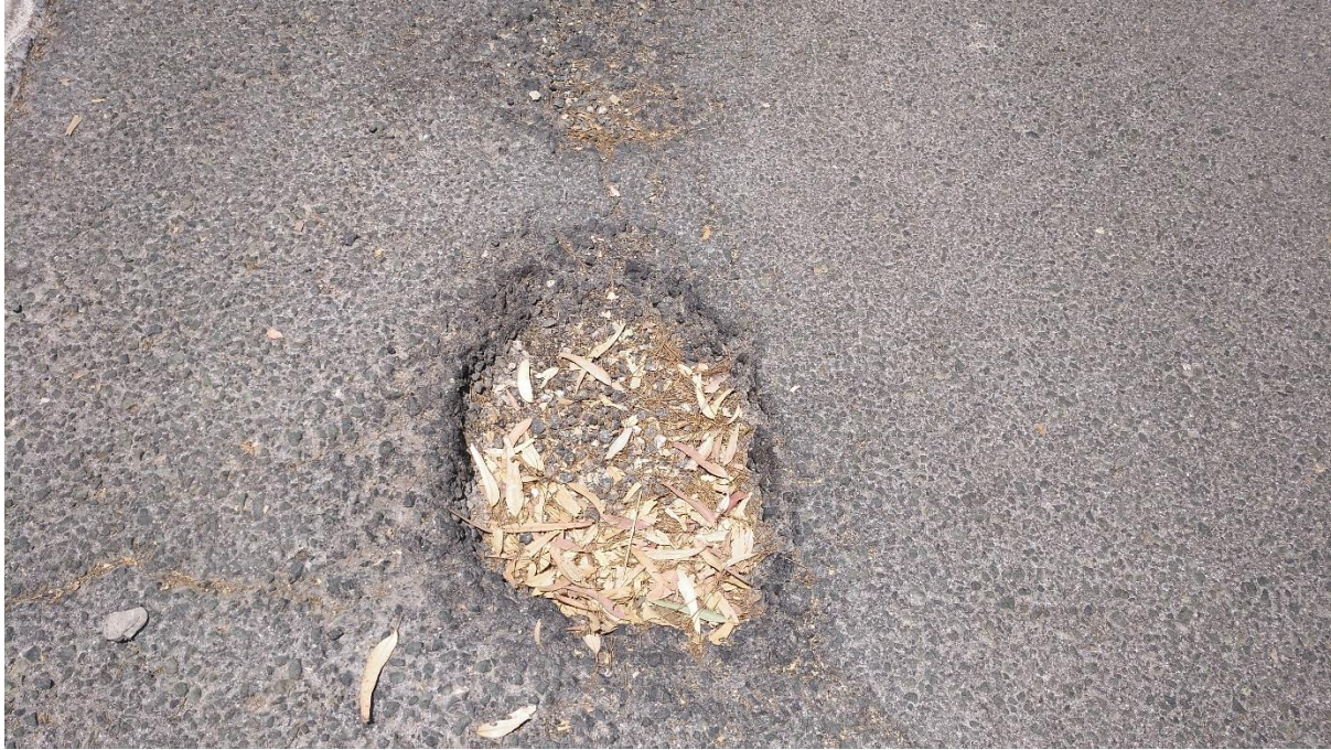
Fotografía 11. Ejemplo de desperfecto en los viales del polígono. Fuente. Elaboración propia.
