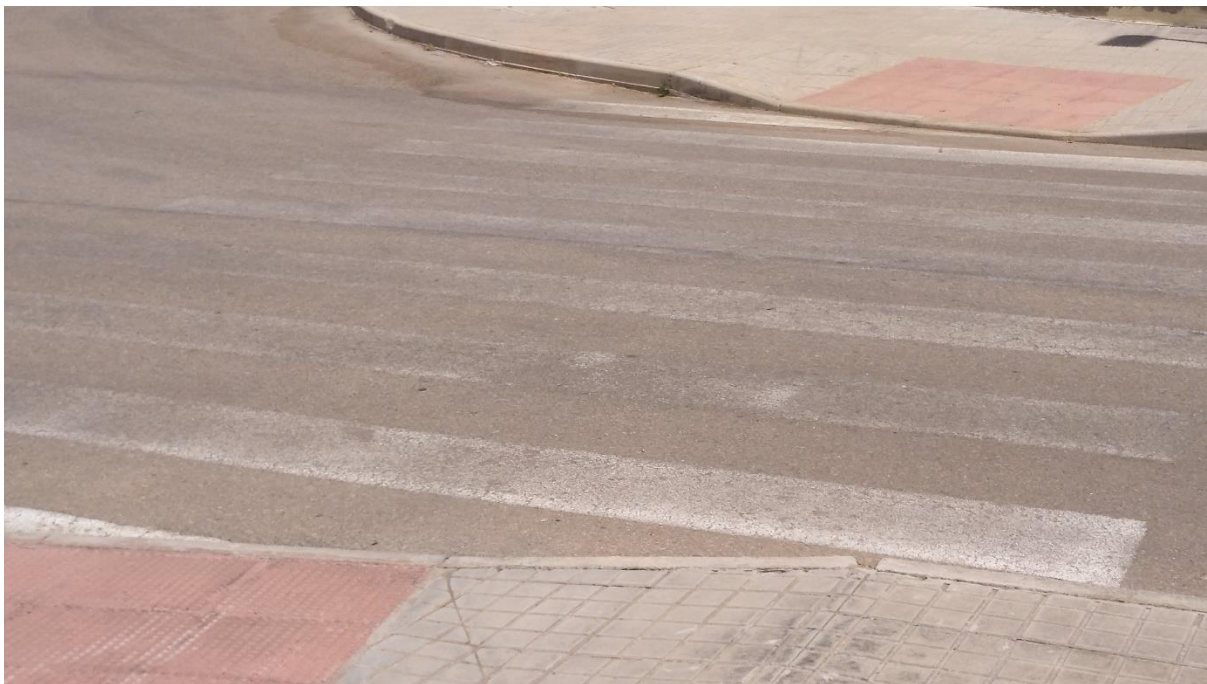
Fotografía 18. Ejemplo estado pintura pasos peatones polígono Crevillente Industrial. Fuente: Elaboración propia
