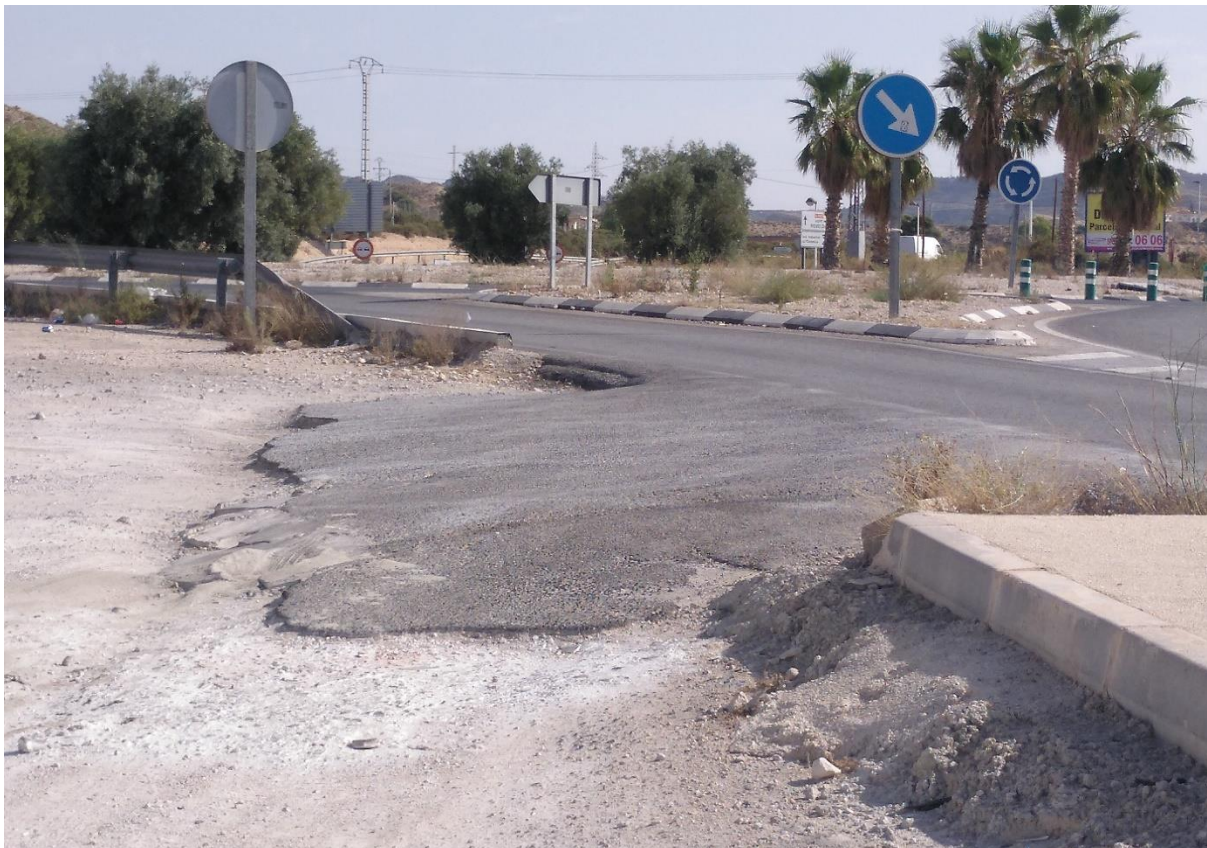
Fotografía 13. Estado acceso nave Sualfombra, polígono Este. Fuente. Elaboración propia.
