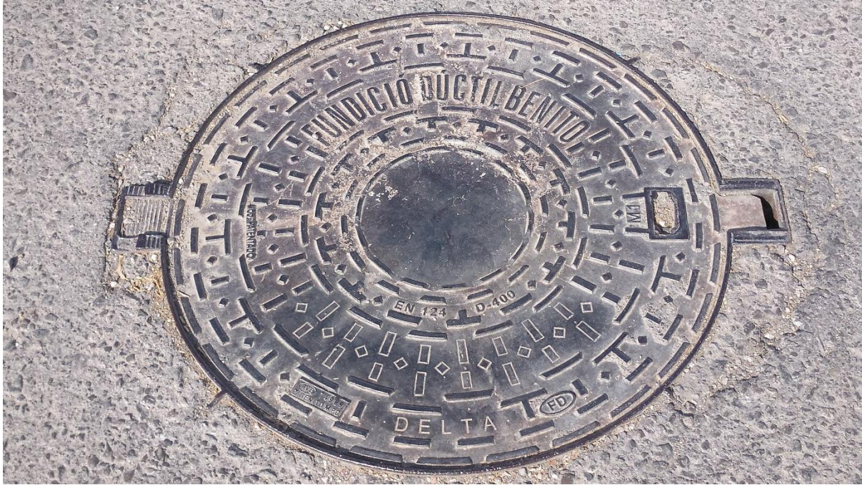
Fotografía 30. Tapa perteneciente a pozo de la red de saneamiento del polígono. Fuente: Elaboración propia.
