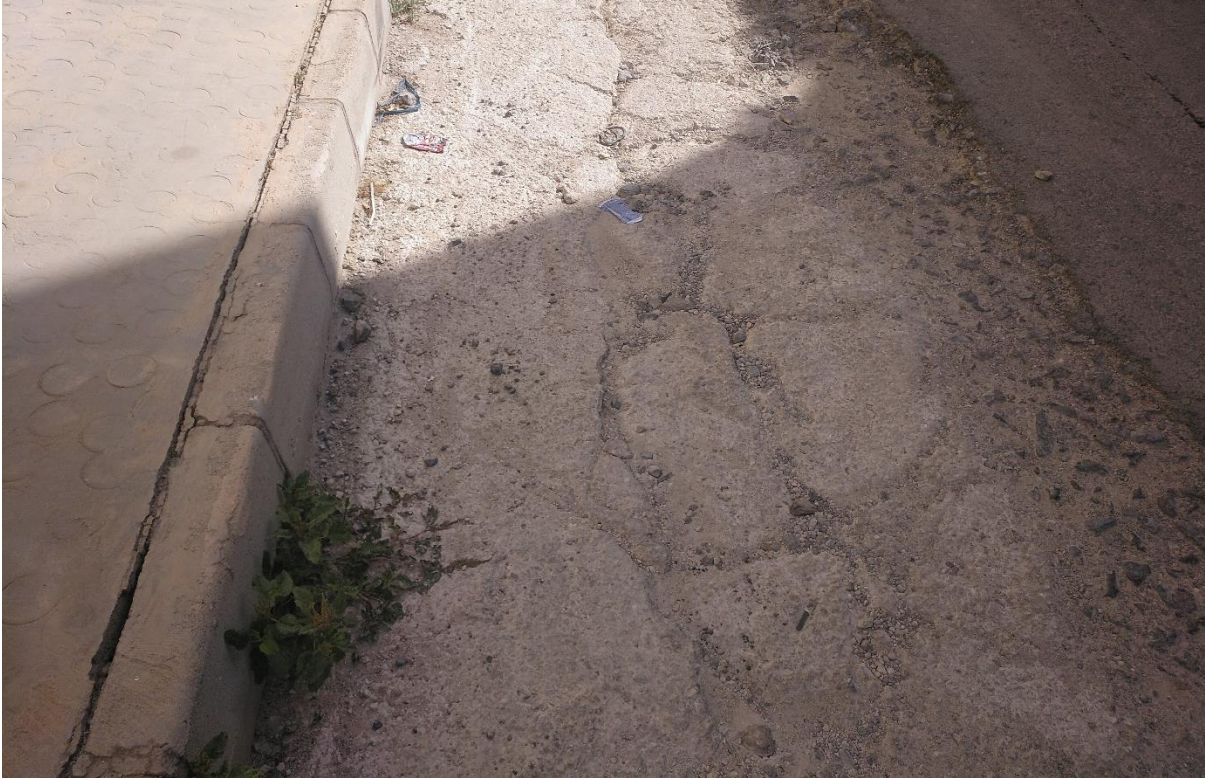
Fotografía 17. Estado pavimento calle polígono Este. Fuente. Elaboración propia.
