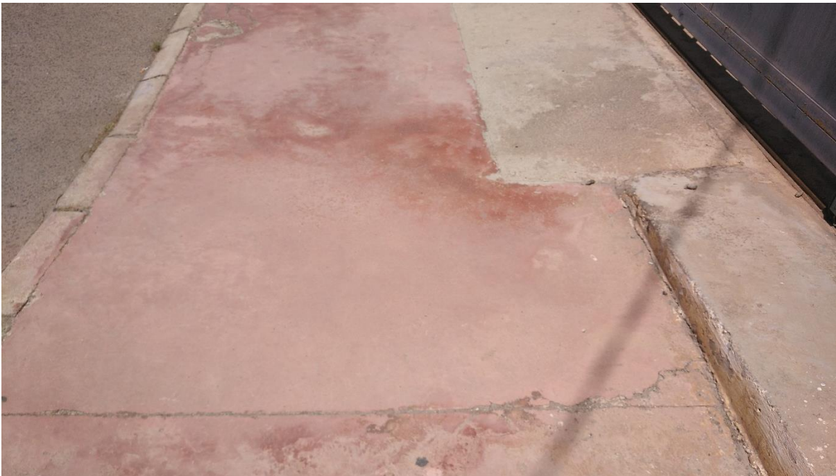
Fotografía 16. Ejemplo del estado de una de las aceras del polígono. Fuente. Elaboración propia.
