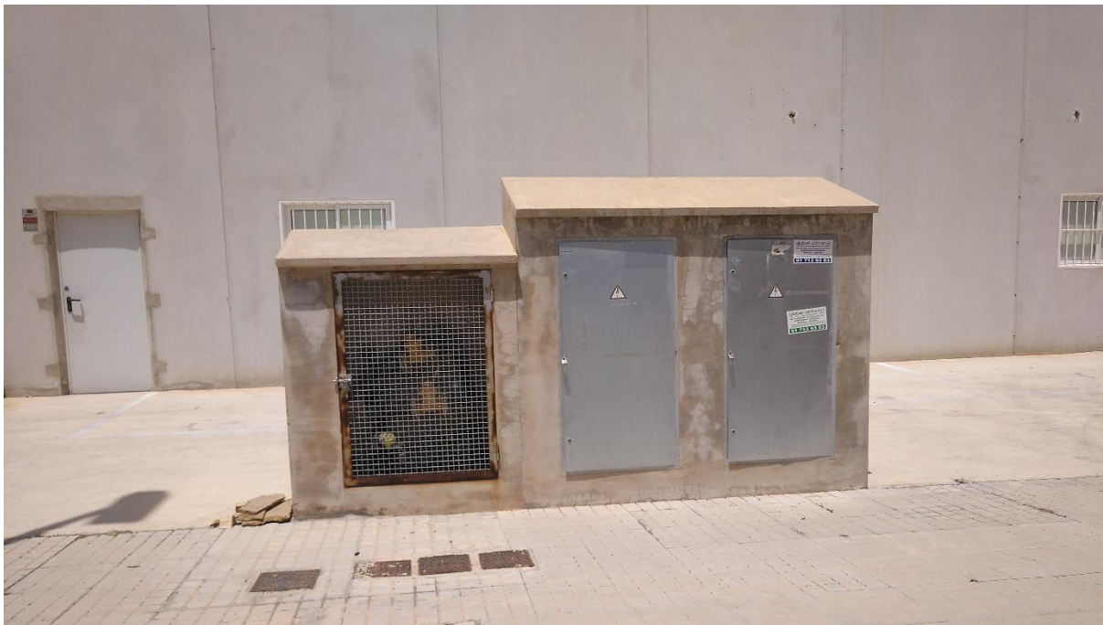
Fotografía 30 . Conexiones para la electricidad del polígono Crevillente Industrial. Fuente: Elaboración propia
