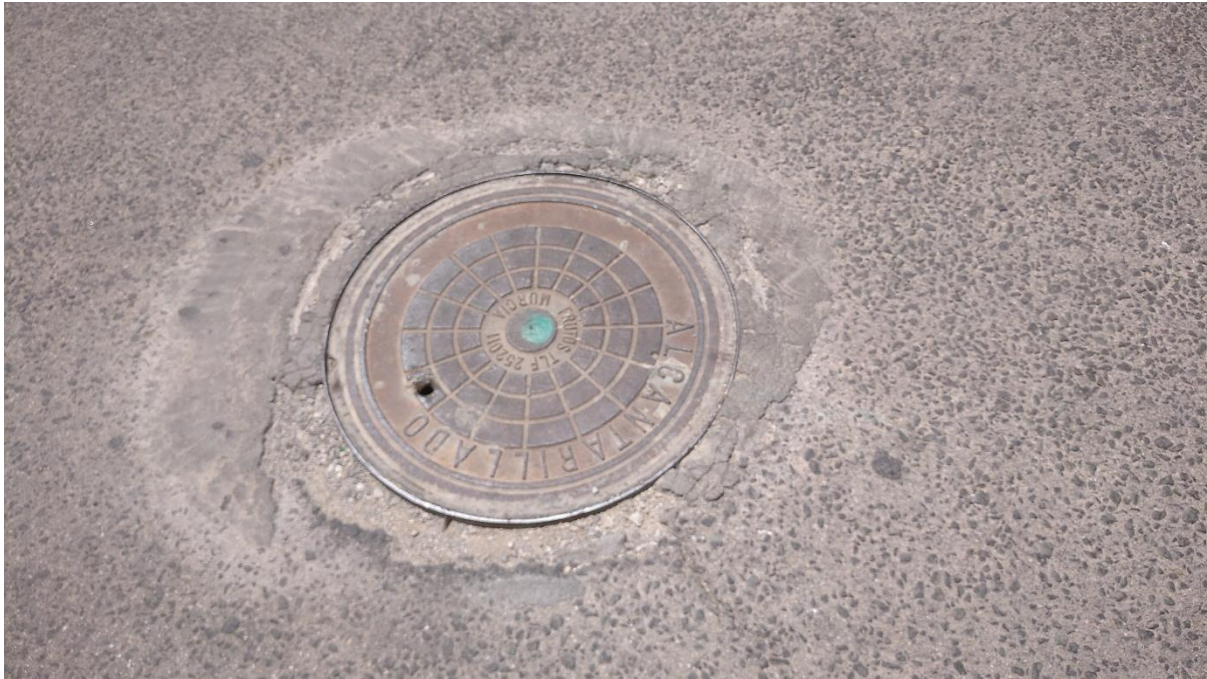
Fotografía 31. Tapa perteneciente a pozo de la red de saneamiento del polígono. Fuente: Elaboración propia.
