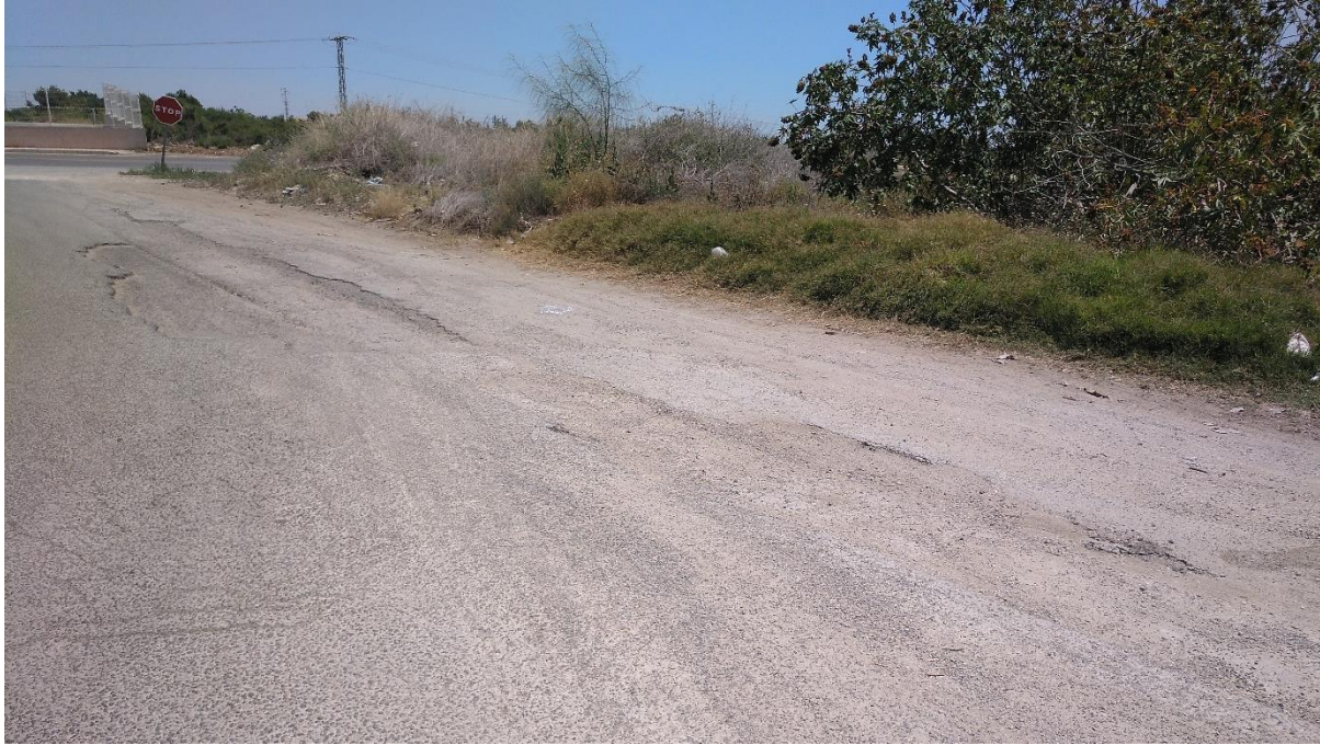
Fotografía 18. Estado del pavimento en la zona sur del polígono junto al acceso. Fuente. Elaboración propia.
