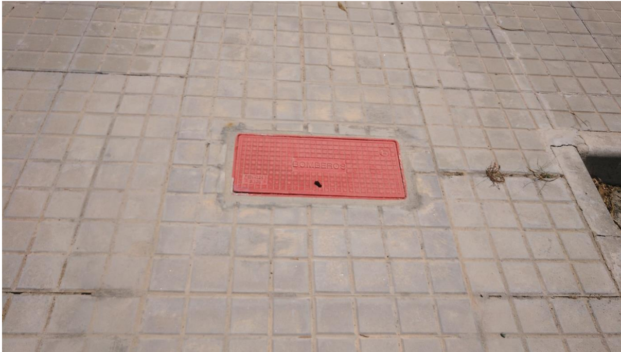
Fotografía 33. Hidrante bajo rasante presente en el polígono Crevillente Industrial. Fuente: Elaboración propia.
