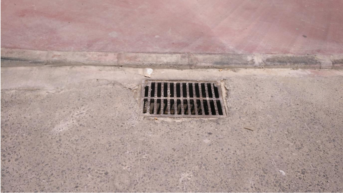
Fotografía 32. Imbornal perteneciente a red de pluviales del polígono. Fuente: Elaboración propia.
