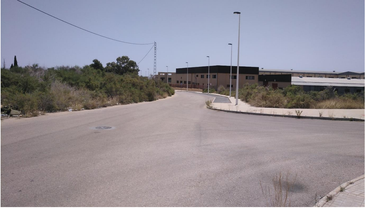
Fotografía 15. C/ Alcoy. Fuente: Elaboración propia.
