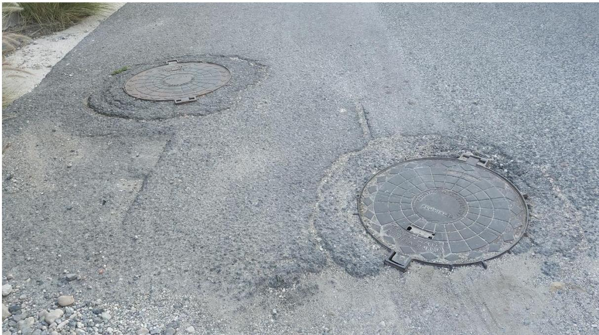
*Fotografía 59. Pozos red de residuales y de pluviales con misma tapa, C/ La Colla Colora. Fuente: Elaboración propia.*
