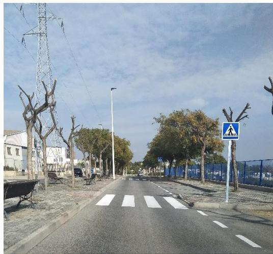
Fotografía 46. Renovación de las luminarias y nuevo marcado de la señalización horizontal.
