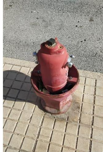
Fotografía 39 y 40. Hidrante de arqueta y de columna. Fuente: Elaboración propia.
