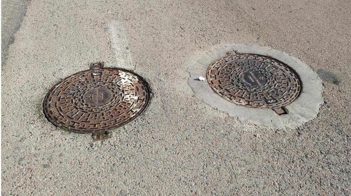
*Fotografía 58. Pozos red de residuales y de pluviales con misma tapa, C/ Ratlla del Bubo. Fuente: Elaboración propia.*
