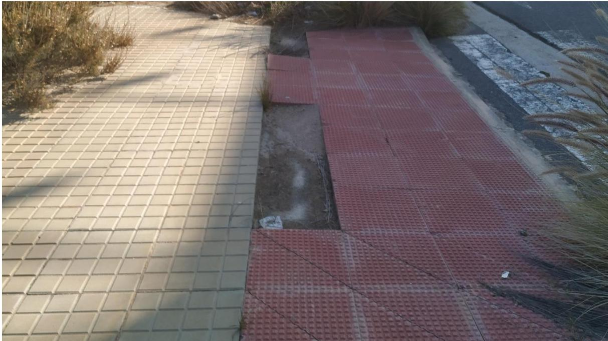
*Fotografía 36. Falta de pavimento en la acera, C/ La Colla Colora. Fuente. Elaboración propia.*
