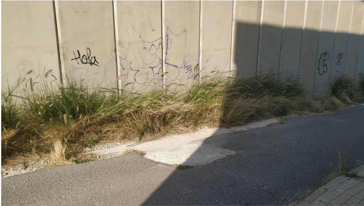
*Fotografía 30. Recorte y falta de asfalto en el vial inferior del muro, C/ Casa del tío Mariano. Fuente. Elaboración propia.*
