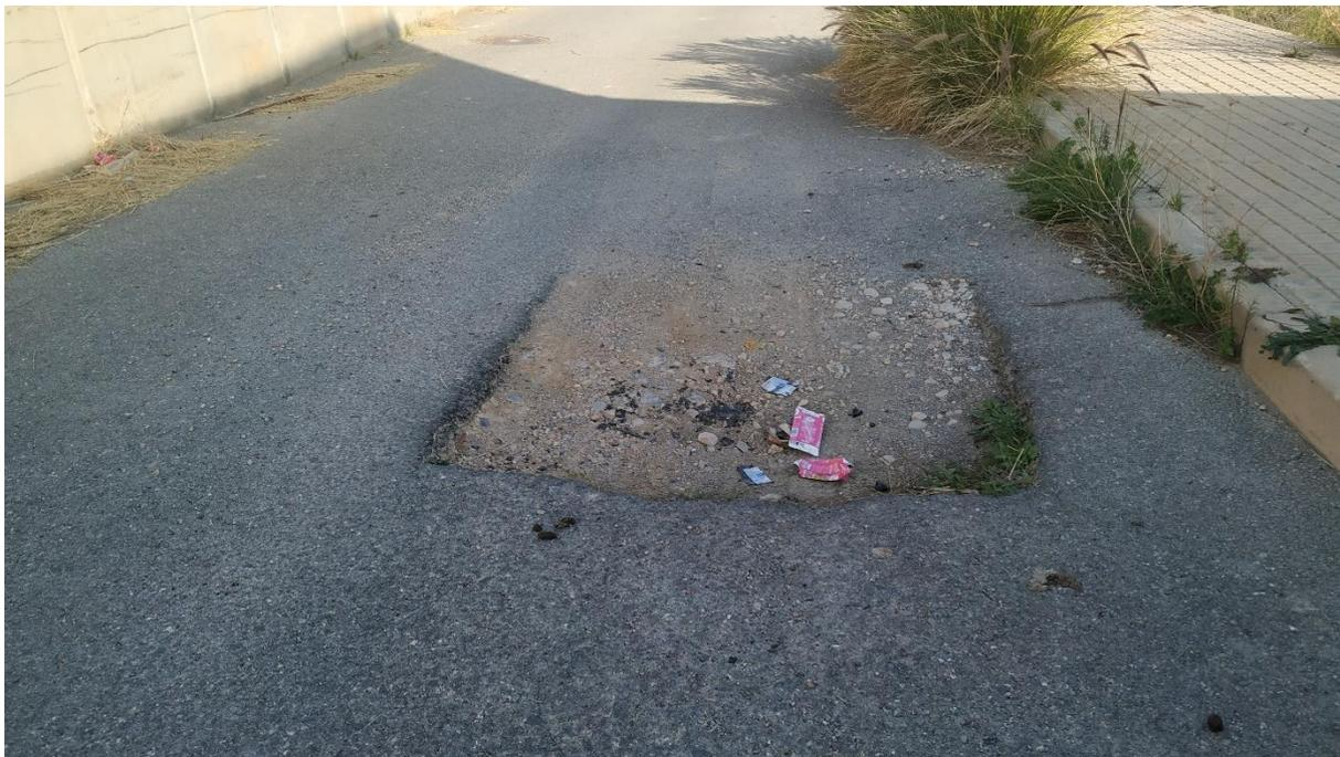
*Fotografía 29. Recortes asfalto en el vial inferior del muro, C/ Casa del tío Mariano. Fuente. Elaboración propia.*
