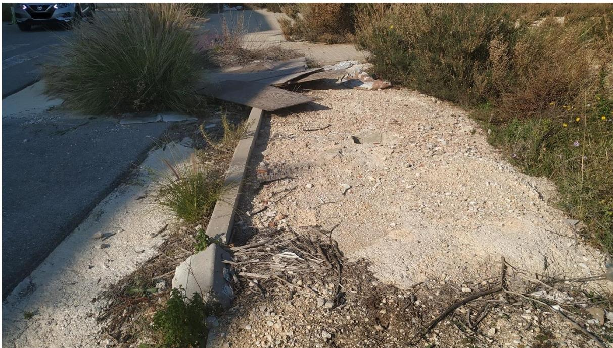
*Fotografía 37. Falta de pavimento en la acera, C/ La Colla Colora. Fuente. Elaboración propia.*
