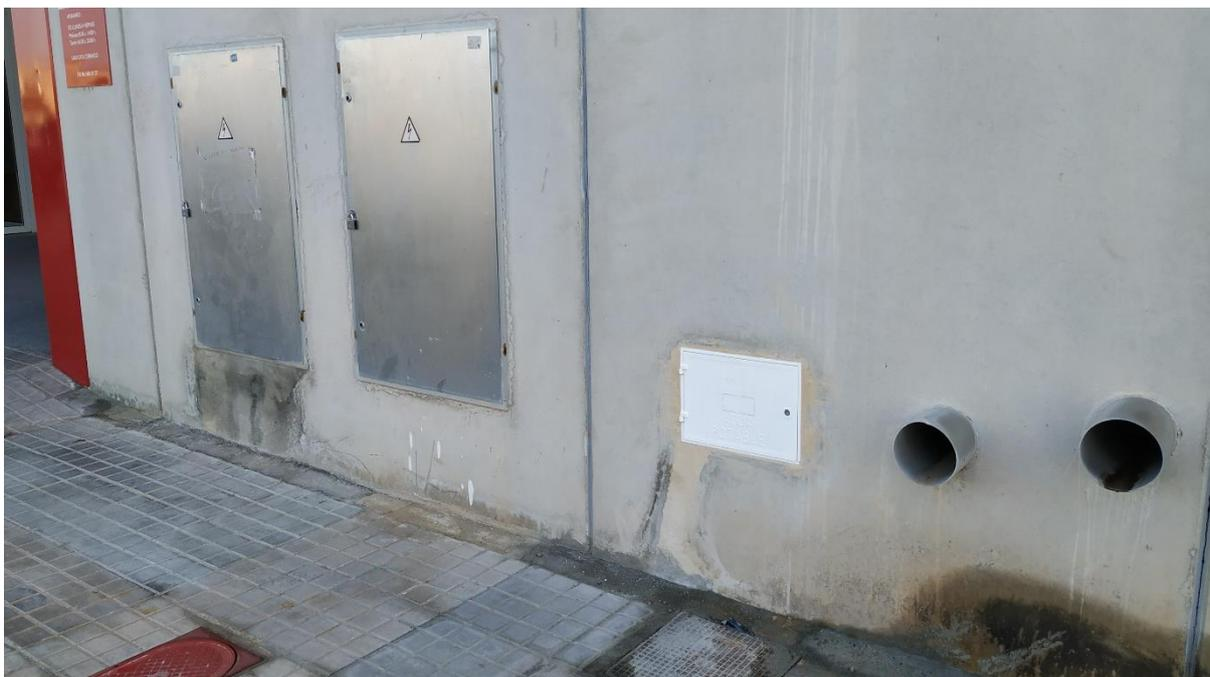
*Fotografía 62. Conexión a red de suministro de agua potable y electricidad. Fuente: Elaboración propia.*
