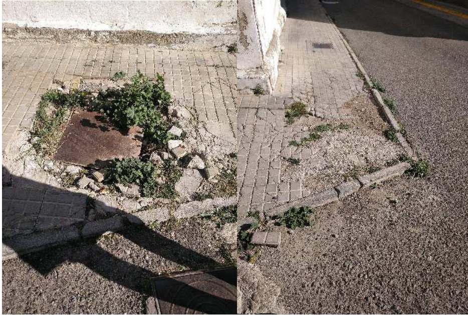
Fotografía 4. Aceras calle interior - Fuente: Elaboración propia
