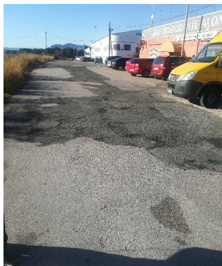
Fotografía 3. Asfaltado calle Altea – Fuente: Elaboración propia
