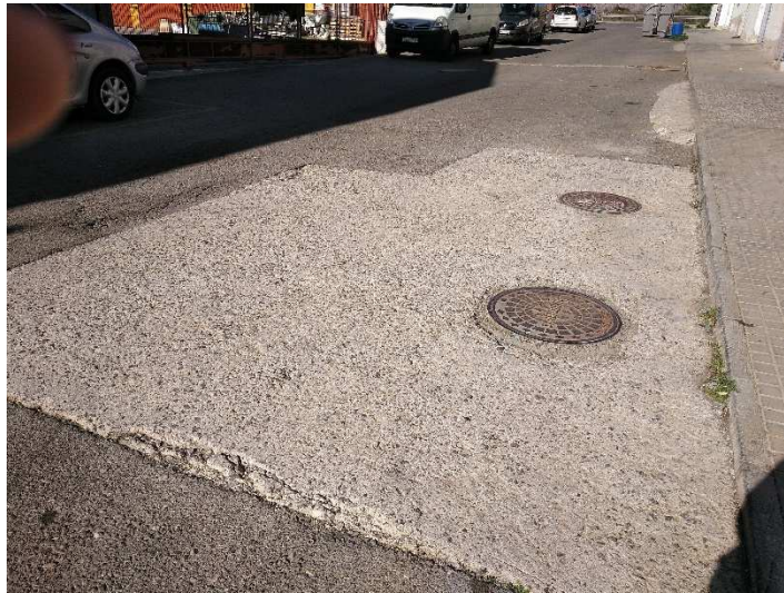
Fotografía 1. Asfaltado calle de acceso al polígono – Fuente: Elaboración propia
