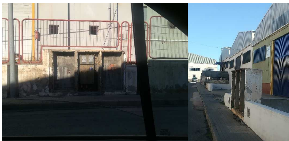
Fotografía 6. Cuadros eléctricos. Fuente: Elaboración propia
